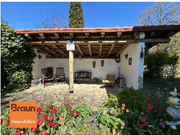
Einfamilienwohnhaus, VS-Schwenningen, Pergola
