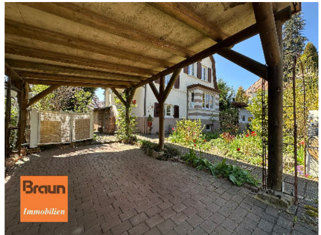
Einfamilienwohnhaus, VS-S, Carport
